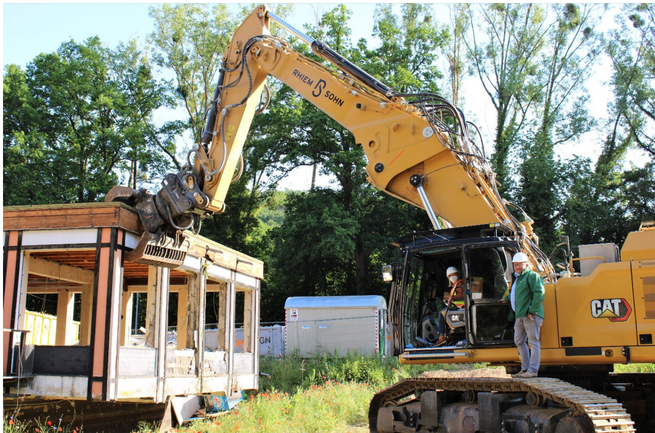
(Foto: L.Huppertz / Stadt Bad Münstereifel: Bürgermeisterin Sabine Preiser-Marian und Herr Klaus Benentreu von der Firma Rhiem und Sohn bei den ersten Abbrucharbeiten des Parkhotels)
